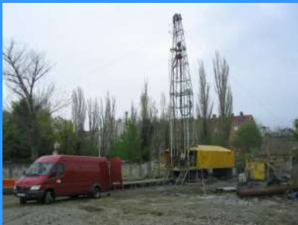
Kút megközelítése építéskor
