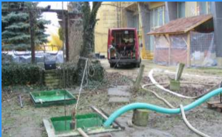
Kút megközelítése építéskor
