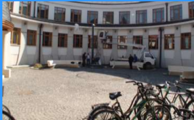
Kút megközelítése (körbe) építés után
